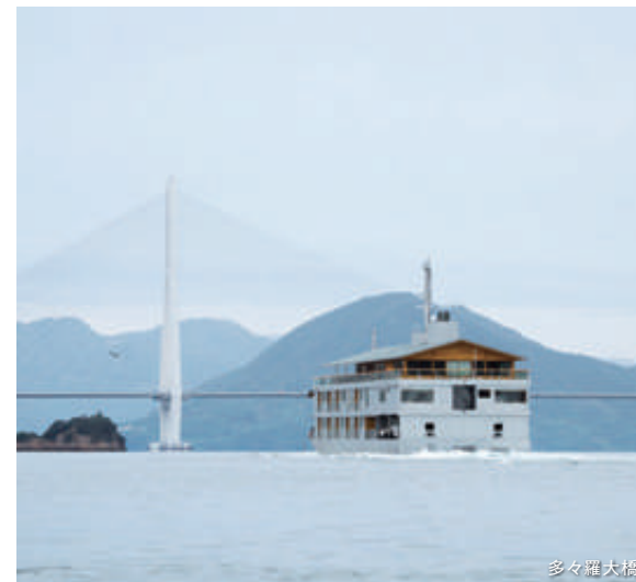
多々羅大橋
