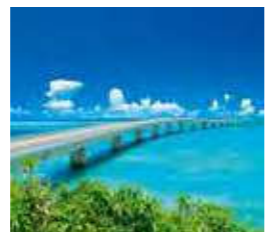
宮古島/伊良部大橋
