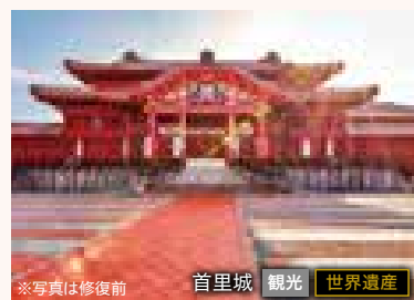
※写真は修復前
